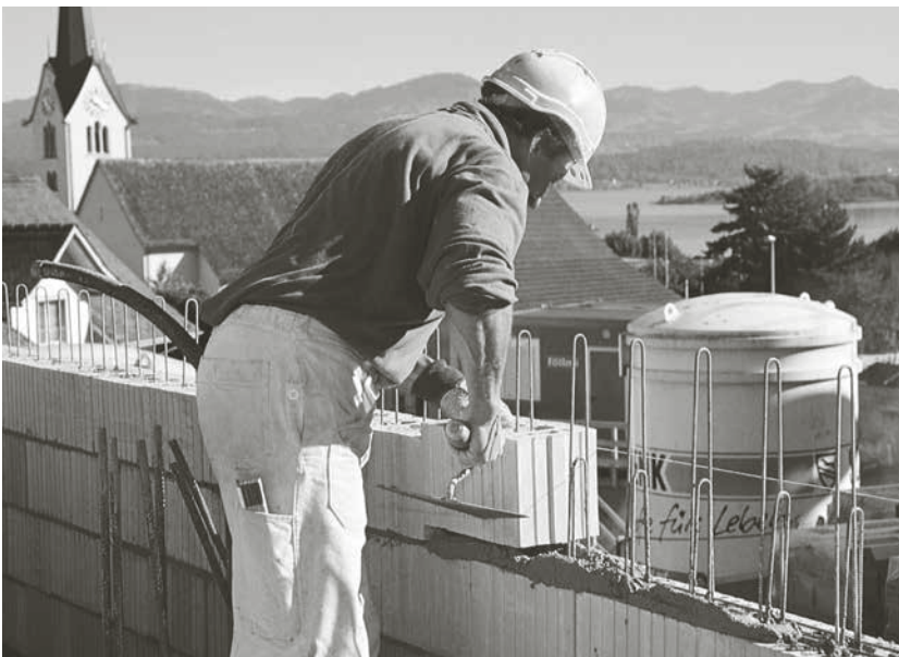
Mehrfamilienhaus-Überbauung in Altendorf SZ
