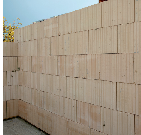
Optimiertes, plangeschliffenes und SIA-konformes Backsteinsystem «EcoModul» mit 1-mm-Dünnbettmörtelfuge.
